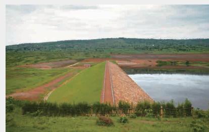
改修された灌漑用ため池の堤体
